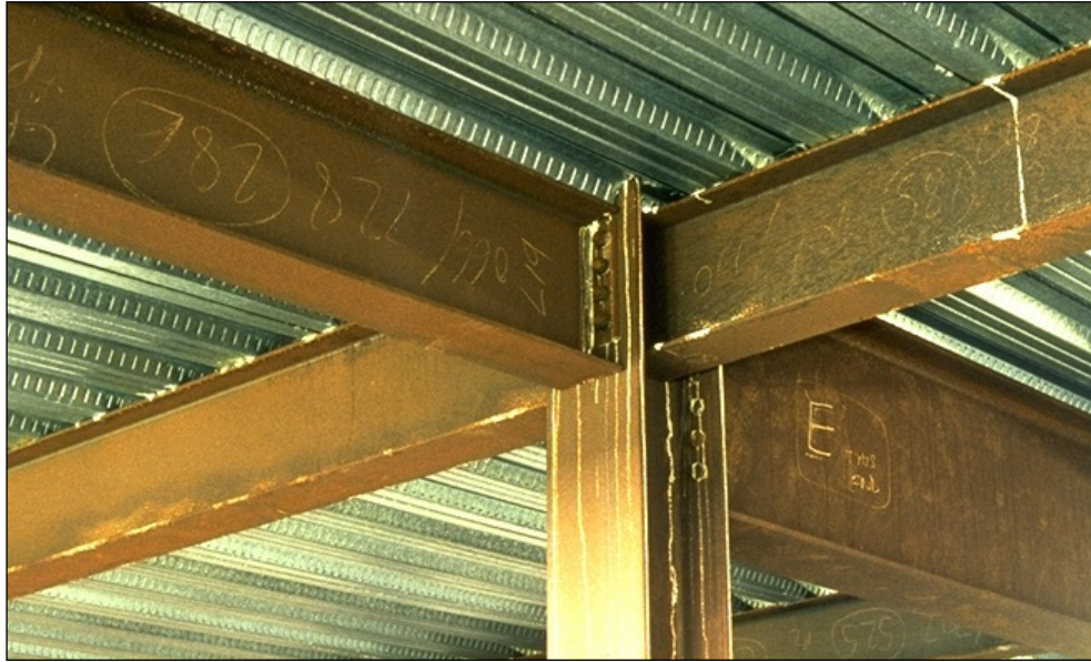
Figuur 1-2 Overzicht van de onbeschermden staalconstructie
