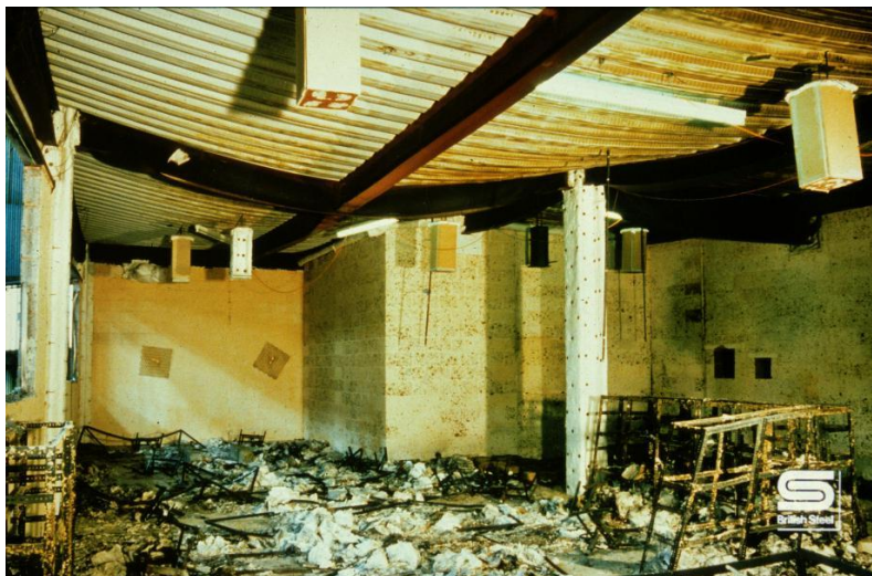
Kuumutatud komposiitvahelae osa deformatsioonid
