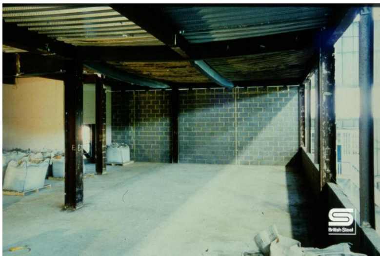
Komposiitvahelae kuumutatud osa deformatsioonid
