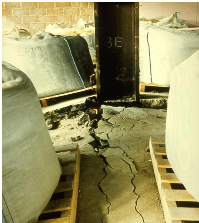
Pragunenud beoon ülekatteta paigaldatudarmatuuri kohal
